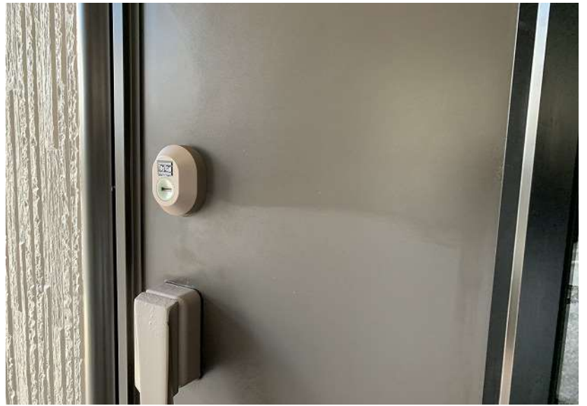
某住宅 FF施工中
