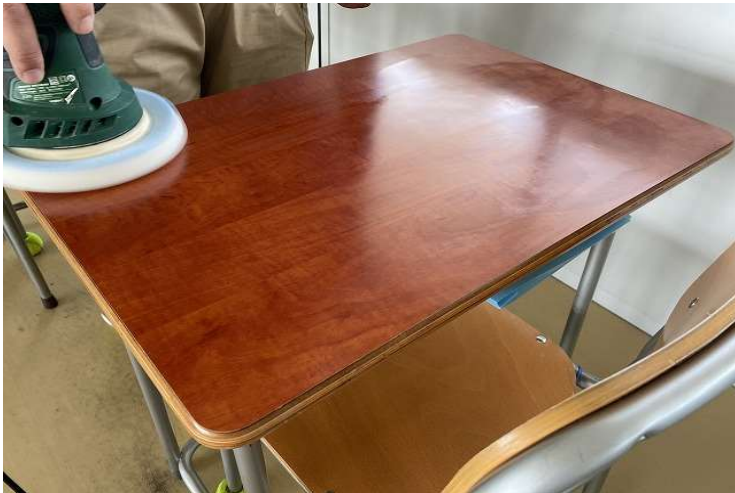
■教室内施工風景
